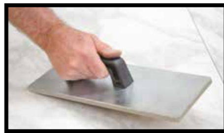
Fig.30 - Una volta posata la lastra occorre far aderire la colla in ogni suo punto evitando così la formazione di vuoti e bolle d'aria. A questo scopo si devono utilizzare frattazzi gommati (ad esempio Raimondi "142G" ).
