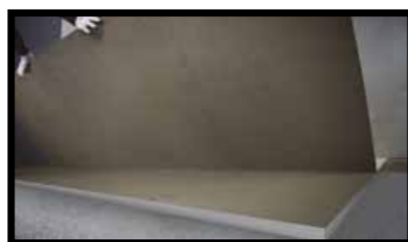
Fig.32 - Vanno posate appoggiando uno dei lati lunghi e quindi accompagnandole sul supporto.
