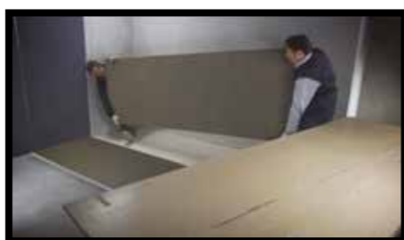
Fig.31 - Vanno movimentate portandole prima in posizione verticale sostenendole per il bordo superiore, quindi muoversi mantenendole sempre rettilinee con l'aiuto di una seconda persona.
